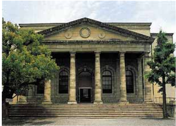
旧表工場正面玄関は旧桜宮公会堂として、今なおその姿を残している。
