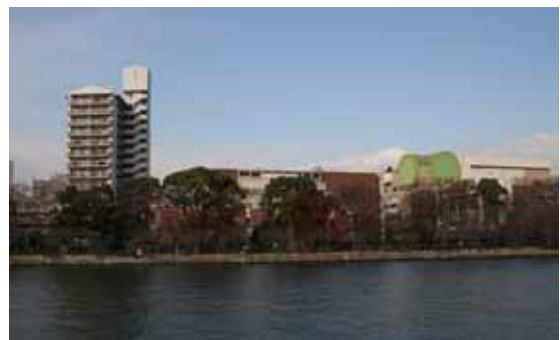
本局の高層化された南宿舎(平成19年)
