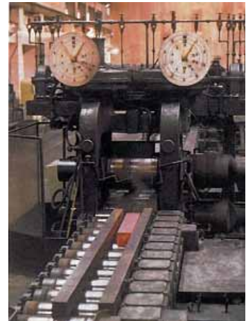
225kw 可逆式熱間圧延機(昭和30年)
