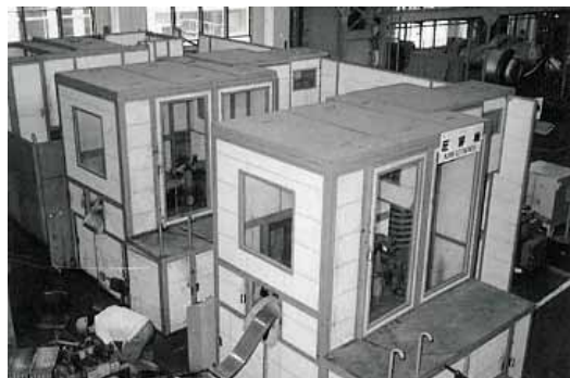
初期の防音装置付圧穿機(昭和40年、東京支局)
