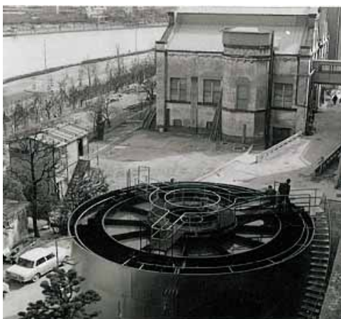
高速凝集沈殿濾過装置(昭和44年)
