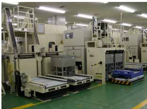
改修された円形・貨幣搬送装置
