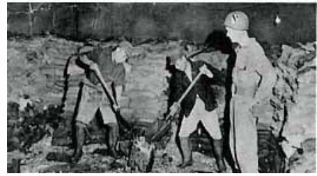
駐留軍監視下での作業
