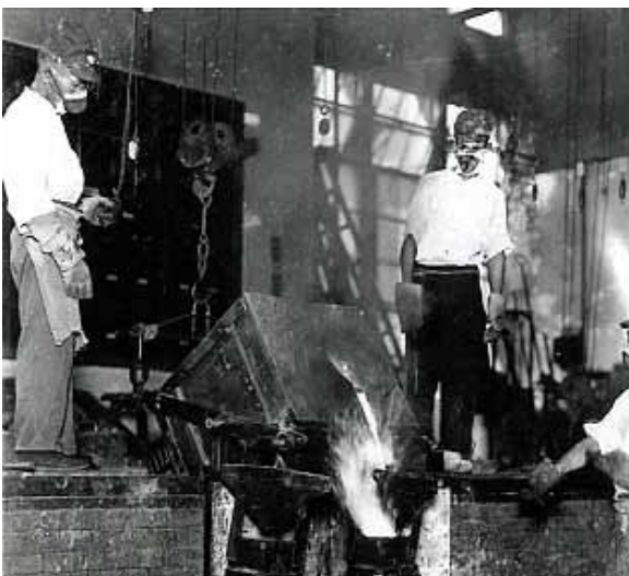
高周波誘導電気炉
