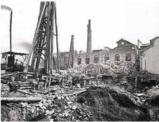
旧表工場の解体作業
